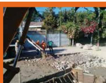
**21** 10/dic: Preparación de capa sub-base para colocación de carpeta asfáltica.
