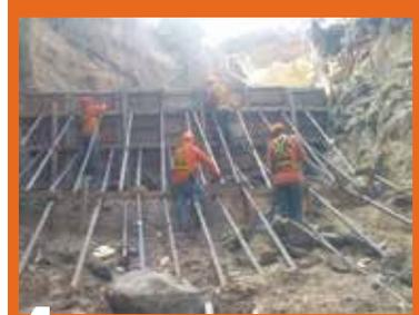
**4** 3/nov: Trabajos de moldeado para relleno en cárcava.
