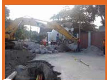
**9** 12/nov: Colocación de suelo cemento semifluido.
