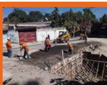
**22** 12/dic: Colocación de mezcla asfáltica (superficie de rodadura).
